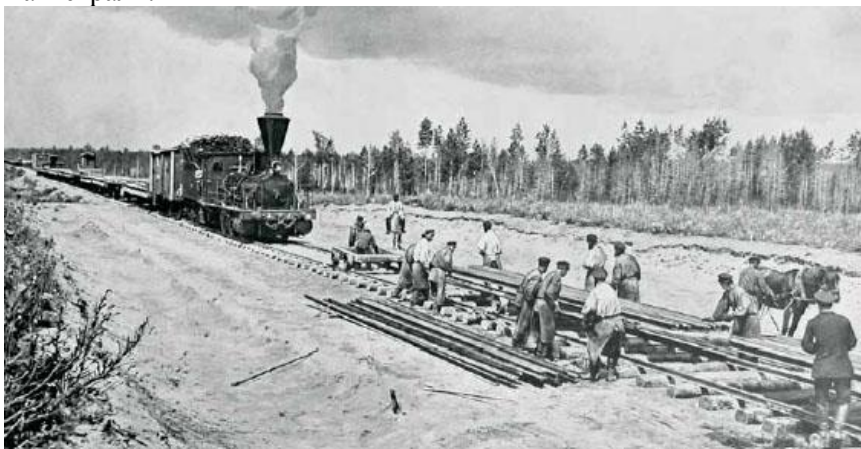
Укладка шпал на строительстве Транссибирской магистрали
